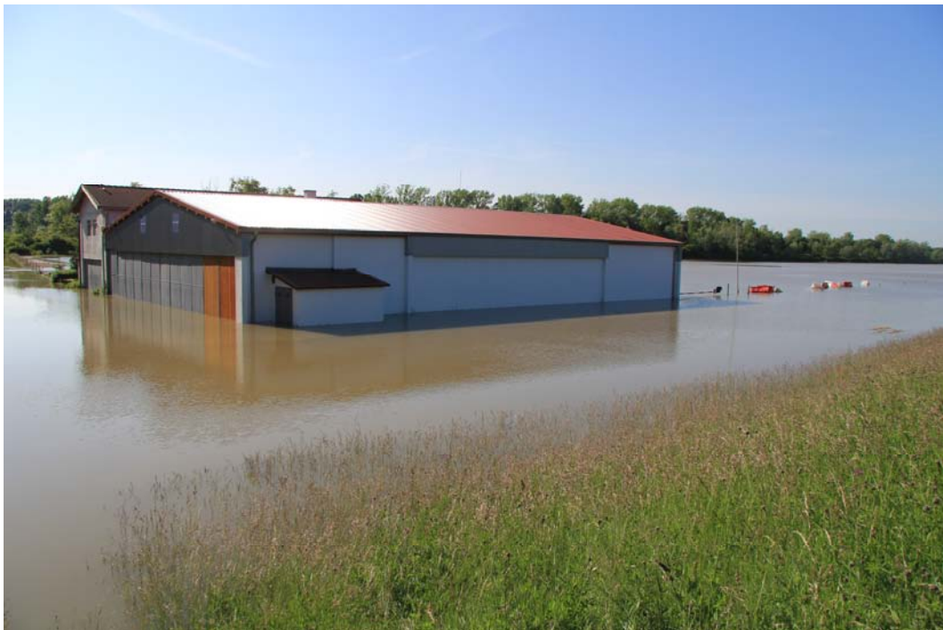
Abb. 3: Überschwemmtes Segelfluggelände in Oppenheim nach Überströmen des Sommerdeichs.
